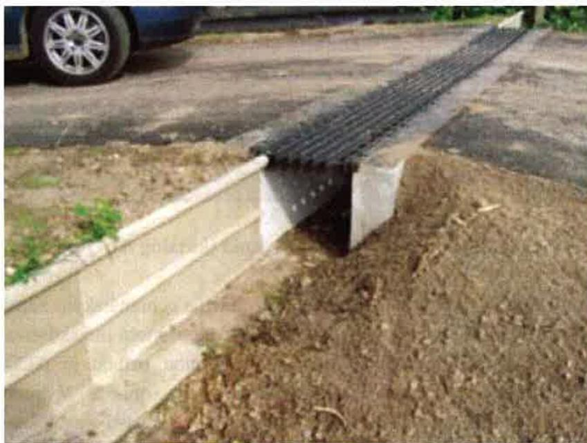
**Obrázok 15** Príklad napojenia zvodidlovej steny na cestný podchod
